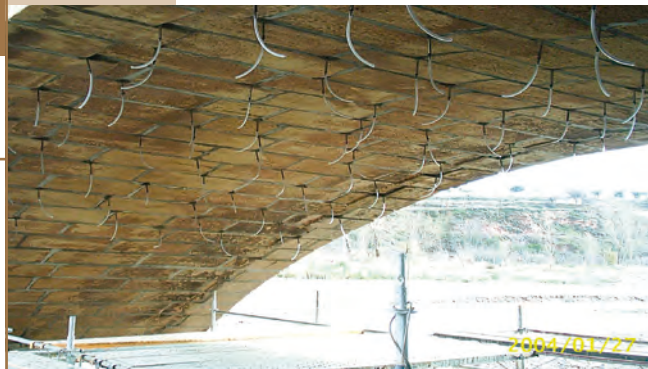
Reparación del hormigón con Resina de inyección epoxi.
