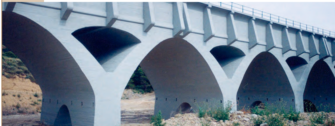
Protección del hormigón mediante Morcemrest Anticarbonatación .
