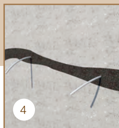
Sellado fisuras de hormigón.
